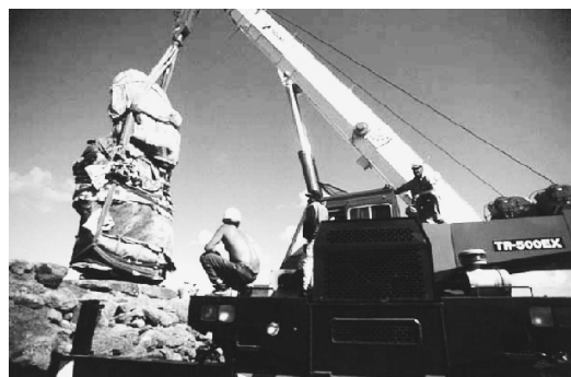
クレーンが「モアイ」を持ち上げる様子
