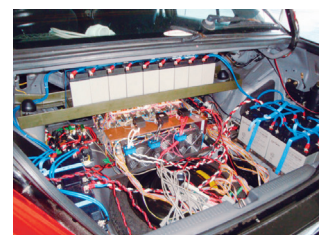
図3 製作したドライバユニット
