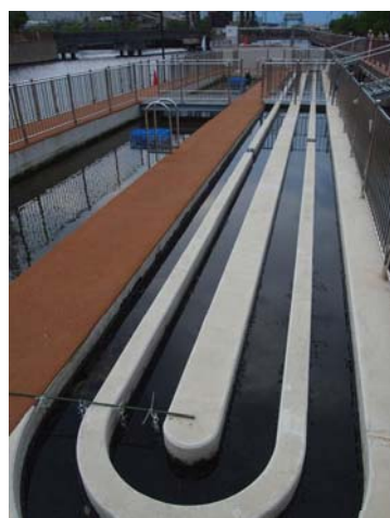
日本一水質悪化の進んだ 新潟運河の水質浄化水路
